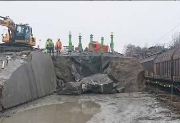
Ovan, till vänster: Den gula sågen jobbar sig igenom berget. Ovan: Den grå terrängmodellen illustrerar var sågen ska gå och den bit berg som ska tas bort. Till vänster: Resultat av sågning och hydraulisk bergspräckning i en känslig miljö intill en tågbanan.
