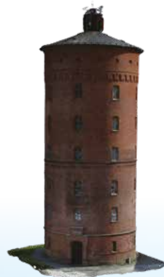
Det gamla vattentornet i Vänersborg som genererats till en 3D-modell från drönarflygning.
